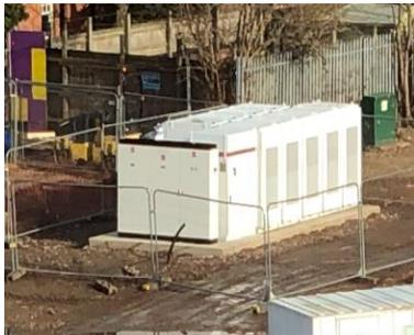
Tesla 2.1MWh Battery - 500kW inverter
